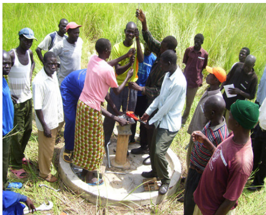
Membri comunitari mentre svolgono attività di manutenzione al pozzo
